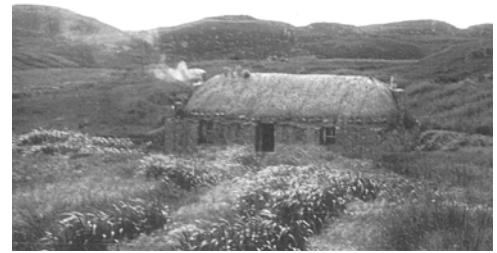
ピートが燃焼する時黒い煙が出ることから「黒い家」と呼ばれる石造り・藁葺きのゲール族の家。
